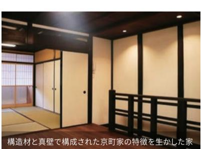
構造材と真壁で構成された京町家の特徴を生かした家
